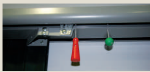
Débrayage manuel du moteur à l'intérieur du garage en cas de panne de courant
